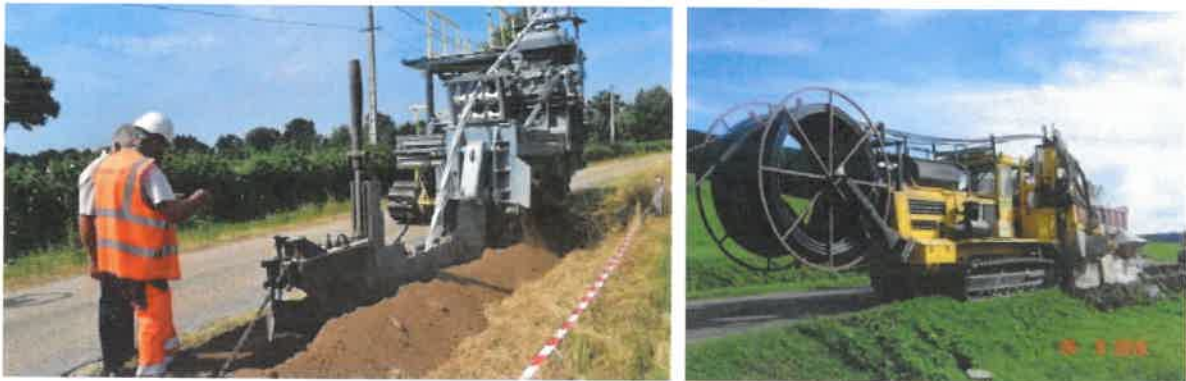
Exemple de trancheuse en action (Source : Le Journal de Saône et Loire ; Tattu TP)
